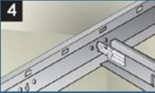
Aunque el elemento secundario se coloque sobre el primario utilizando sólo uno de sus extremos, el cierre es automático e inmediato.
